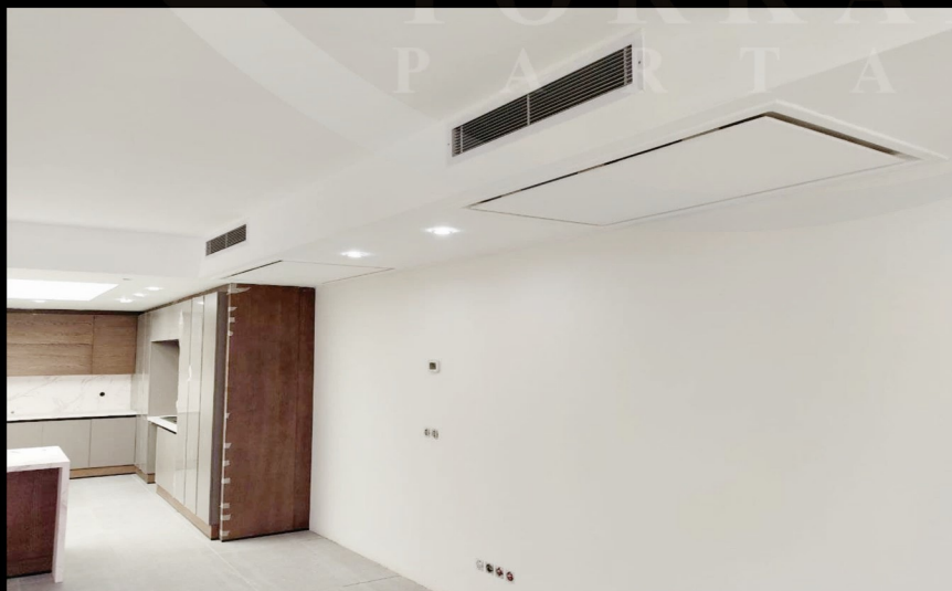
دریچه دسترسی گل سقفی وزنی مدل لولایی با مگنت
